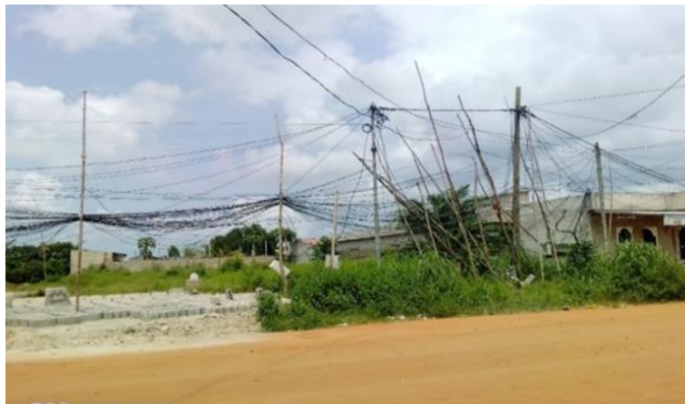
Photo 2 : Un réseau de branchement anarchique le long d'une voie à Kpontavi
