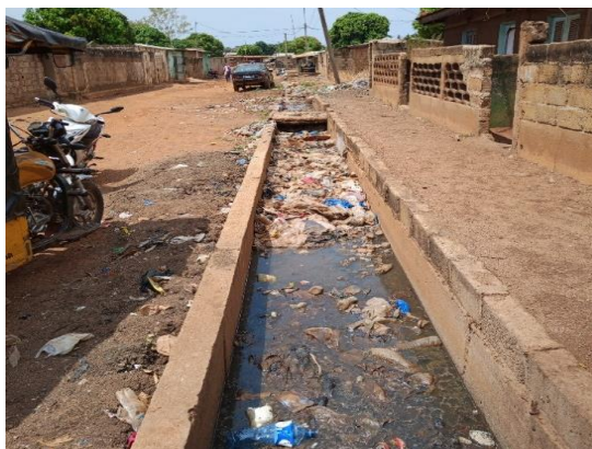
Photo n°2 : Un caniveau obstrué par des déchets ménagers au quartier Haidara
