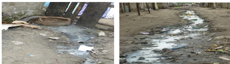
Photo n°2 : Evacuation des eaux usées
