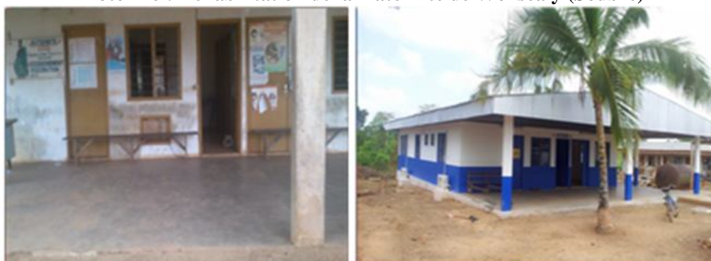
Photo n°6 : Réhabilitation de la maternité de Wonséaly (Soubré)
